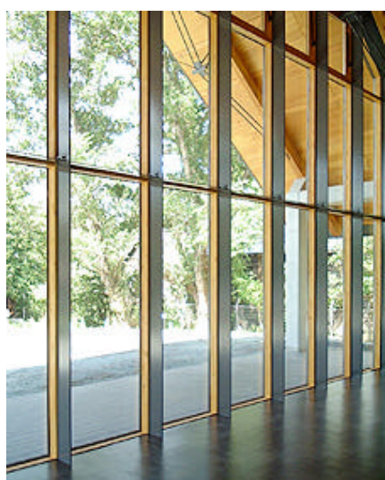
i-ウッドスクリーンシステムを 利用したカーテンウォール
