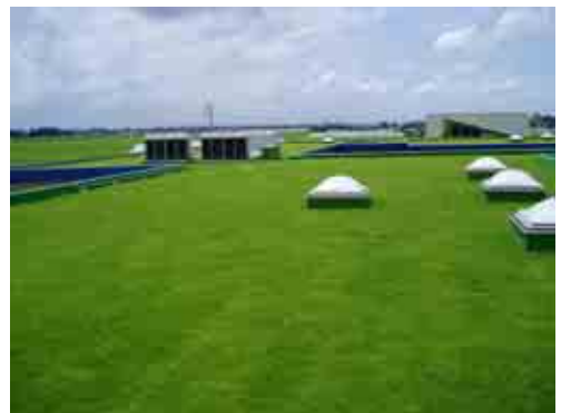
スタンダードタイプを使用した施工例 高麗芝(群馬県館林市老人ホーム屋上緑化)
