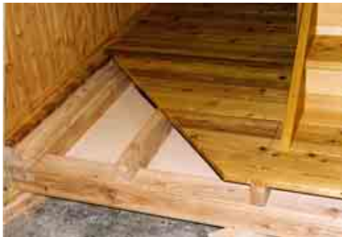
カラマツ集成材 防腐・防蟻処理材
