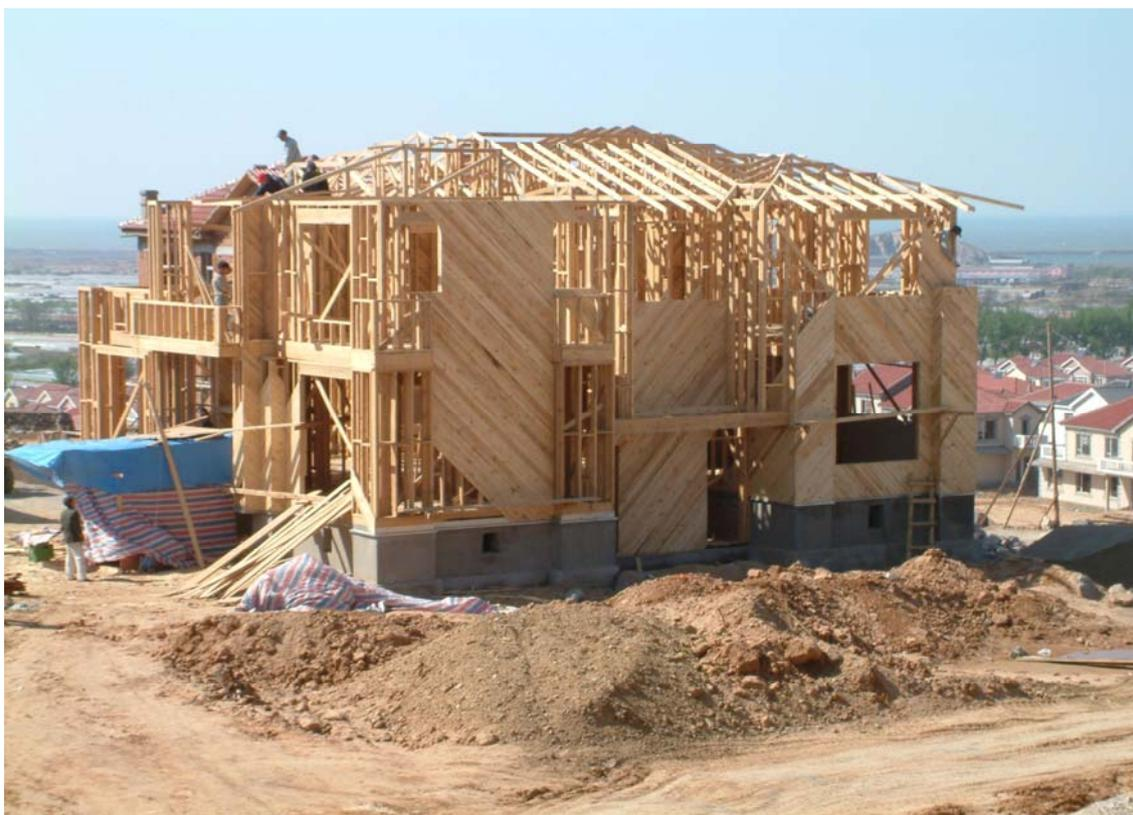
大連での木造住宅の施工（外壁板張り）
