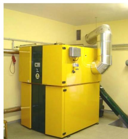
図 II-3-8 小規模地域熱供給事業で用いられている小型チップボイラー (150kW)
