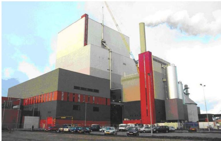
図 II -2-20 Amer-9 石炭炊き発電所と木質バイオマスガス化炉（向かって右側）<sup>13)</sup>
