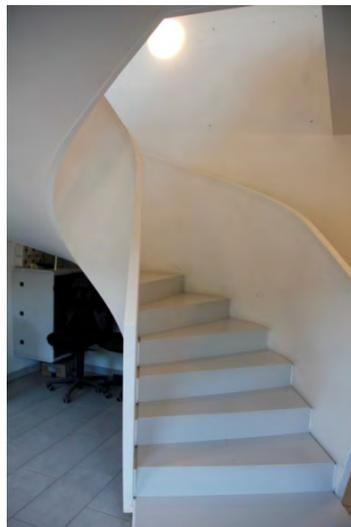
図 II -3-41 木造階段（展示品のため、踏み台には鉄板が敷いてある）
