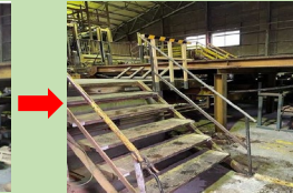
手すりや柵の設置
