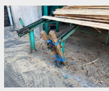
壊れた状態 応急処置のまま
