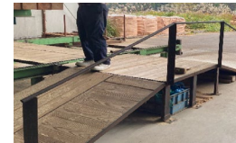
手すり、柵を設置
