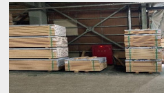
消火栓を資材を塞いでいる
