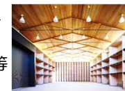
CLTを活用した設計・建築実証
