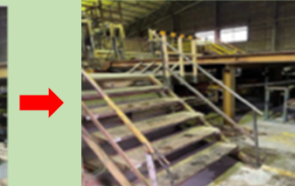
手すりや柵の設置
