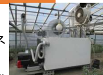
ヒートポンプ
