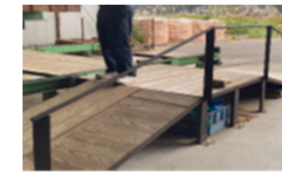
手すり、柵を設置
