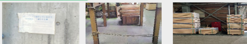
日に焼けている注意喚起 注意内容が不明確 消火栓を資材を塞いでいる
