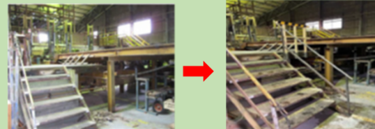
改善前 手すりや柵の設置 改善後
