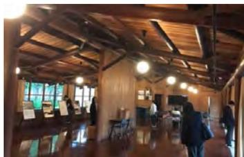
レーモンドホール：1951年に三重県立大学の図書館として建築。棟木・母屋・垂木・火打梁など丸太材で構成された架構をそのまま表して表現。軒出も深くしている。1969年、現在の場所に移転され、2020国登録有形文化財に登録され、2013年保存改修工事がされ、現在に至る。
